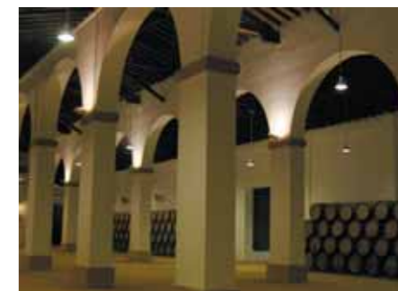
Nave de crianza de la Bodega Vinícola del Condado en Bollullos par del Condado
